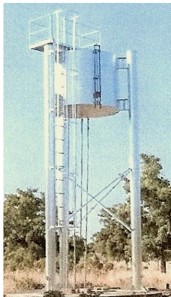
Voici un château d'eau à Kalzi au B.F.
